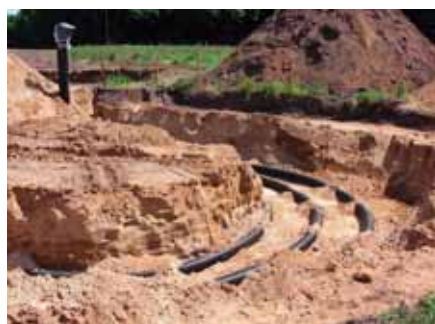
Pose des 3 conduits EGT flexibles
